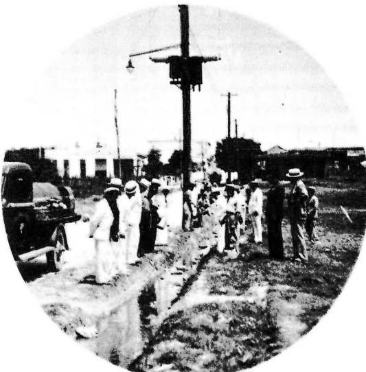
Una de las numerosas zonas colectoras de aguas de albañal del reparto San Antonio, en el barrio del Príncipe.
